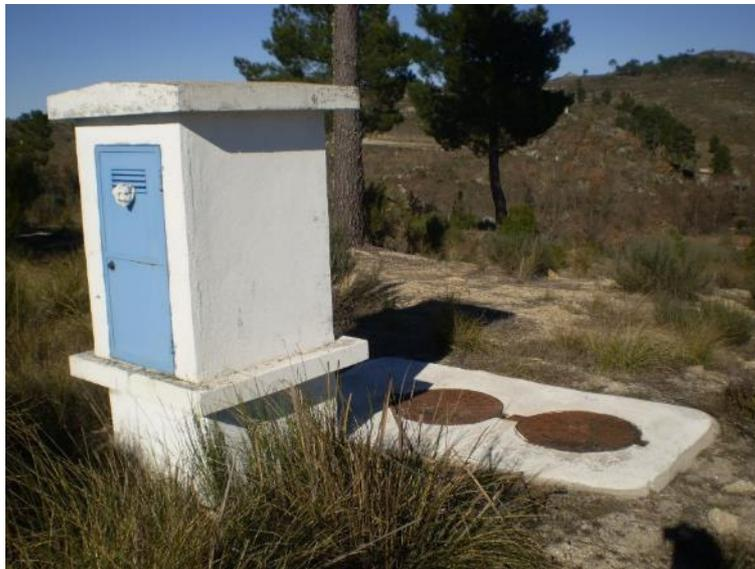
Figura 53: Câmara de manobra da conduta adutora gravítica que cruza a área do Plano
