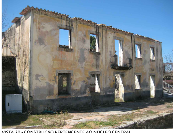
VISTA 20 - CONSTRUÇÃO PERTENCENTE AO NÚCLEO CENTRAL
