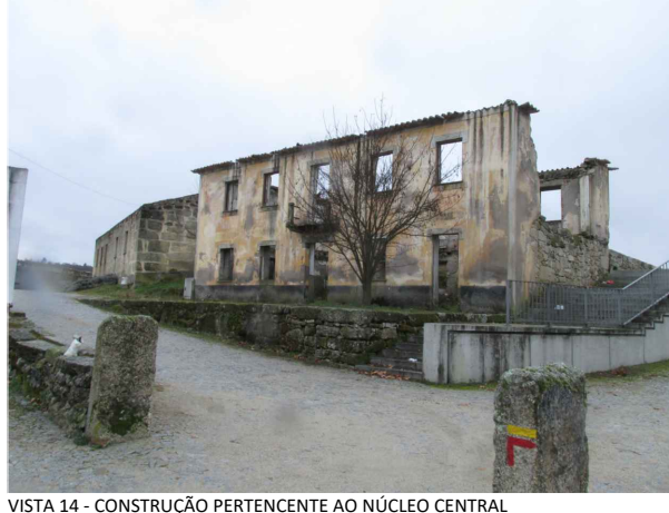
VISTA 14 - CONSTRUÇÃO PERTENCENTE AO NÚCLEO CENTRAL
