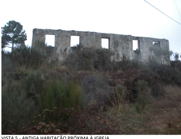
VISTA 5 - ANTIGA HABITAÇÃO PRÓXIMA À IGREJA
