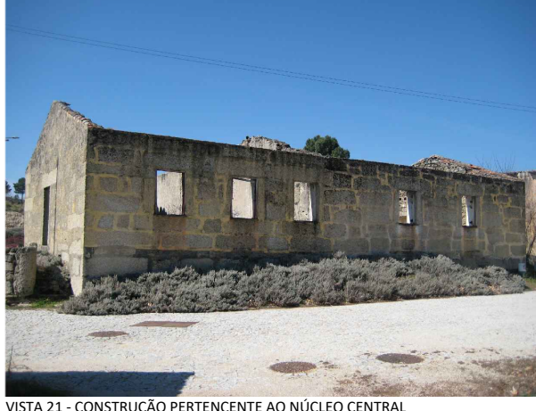
VISTA 21 - CONSTRUÇÃO PERTENCENTE AO NÚCLEO CENTRAL
