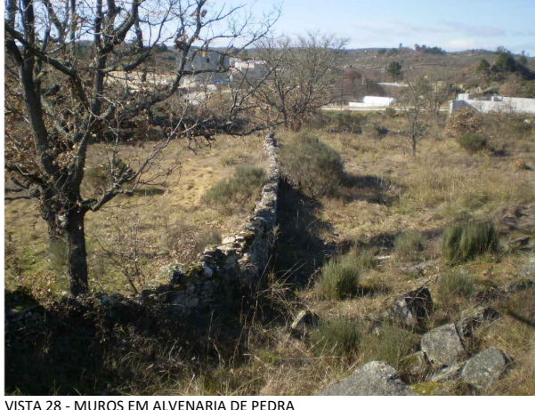
VISTA 28 - MUROS EM ALVENARIA DE PEDRA
