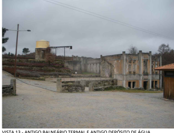
VISTA 13 - ANTIGO BALNEÁRIO TERMAL E ANTIGO DEPÓSITO DE ÁGUA
