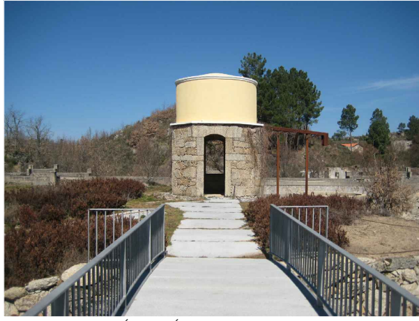
VISTA 17 - ANTIGO DEPÓSITO DE ÁGUA
