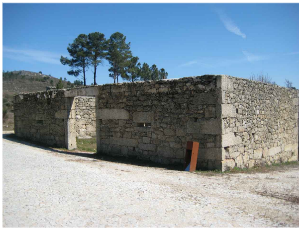
VISTA 22 - CONSTRUÇÃO PERTENCENTE AO NÚCLEO CENTRAL
