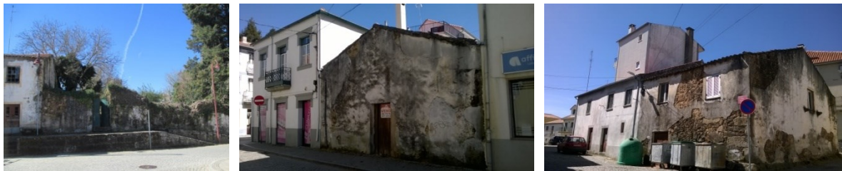
Figura 39. Exemplos de imóveis degradados, focos de desqualificação do ambiente urbano
