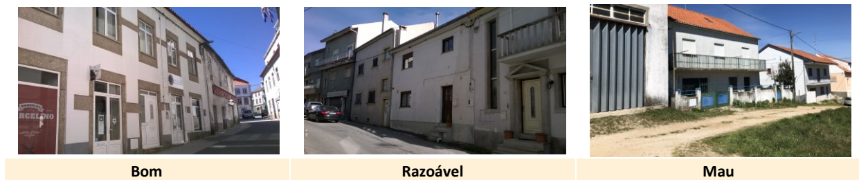
Figura 21. Exemplos do estado de conservação dos espaços de circulação da ARU
