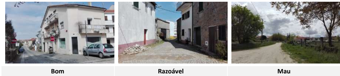
Figura 23. Exemplos do estado de conservação dos espaços de circulação da ARU
