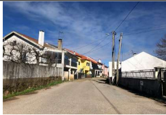
Rua das Passadeiras
