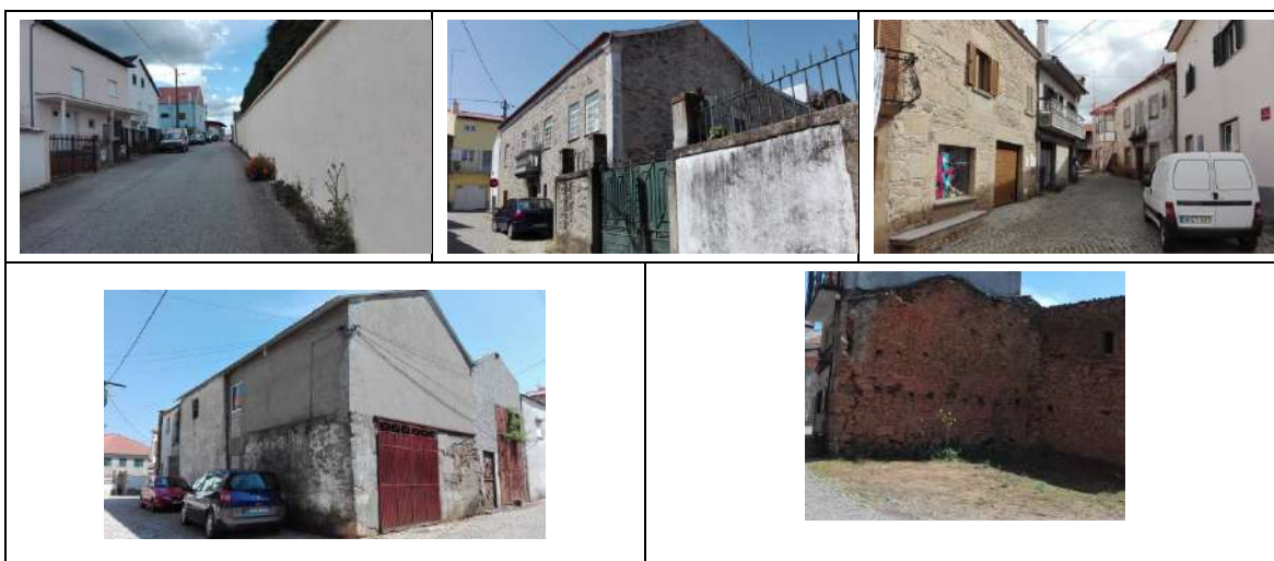
Figura 26. Exemplos de estacionamento informal na ARU
