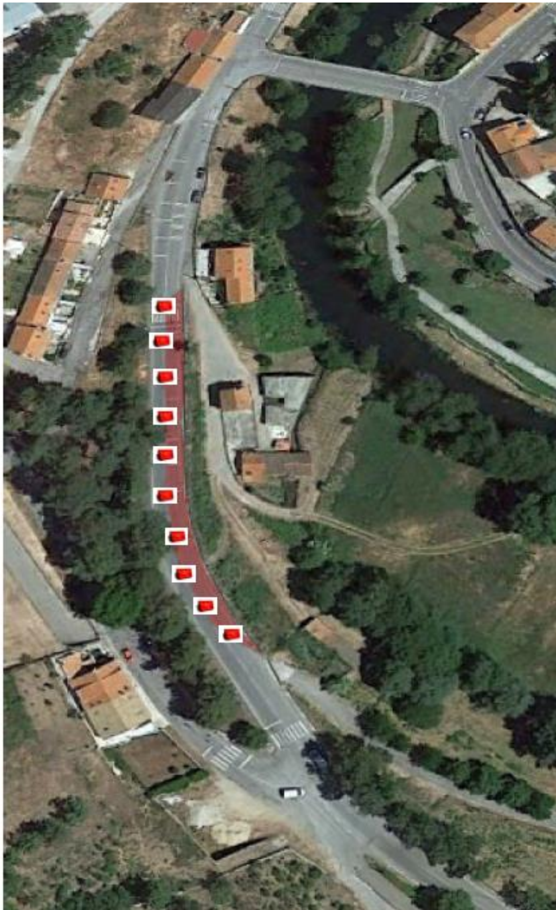
Figura 3 _Delimitação da Via afetada pela intervenção no talude da EN233
