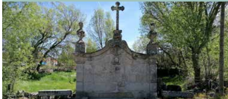
Fonte dos Prados | Prados fountain
