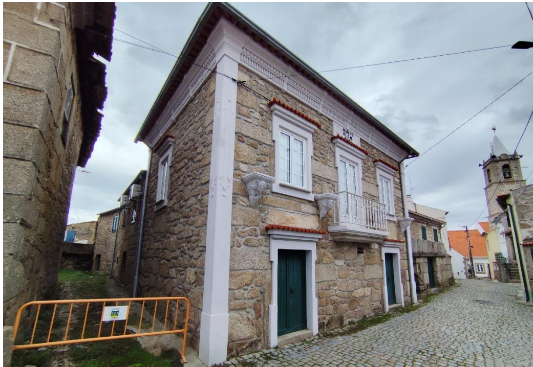
Figura 5 – perspectiva sobre a Rua da Igreja
