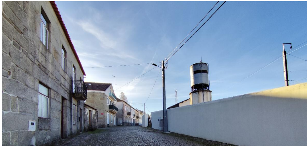
Figura 4 – perspectiva sobre Rua Doutor Joaquim Dinis da Fonseca, imediações da estação ferroviária
