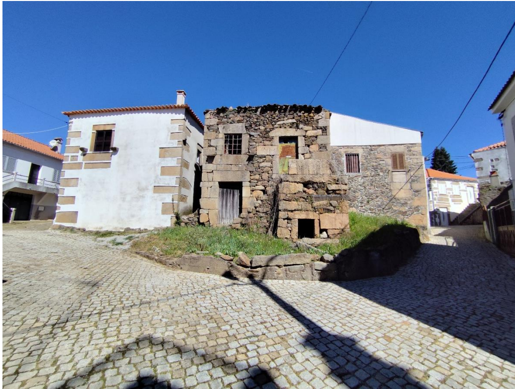
Figura 4 – perspetiva sobre Rua de Cimo
