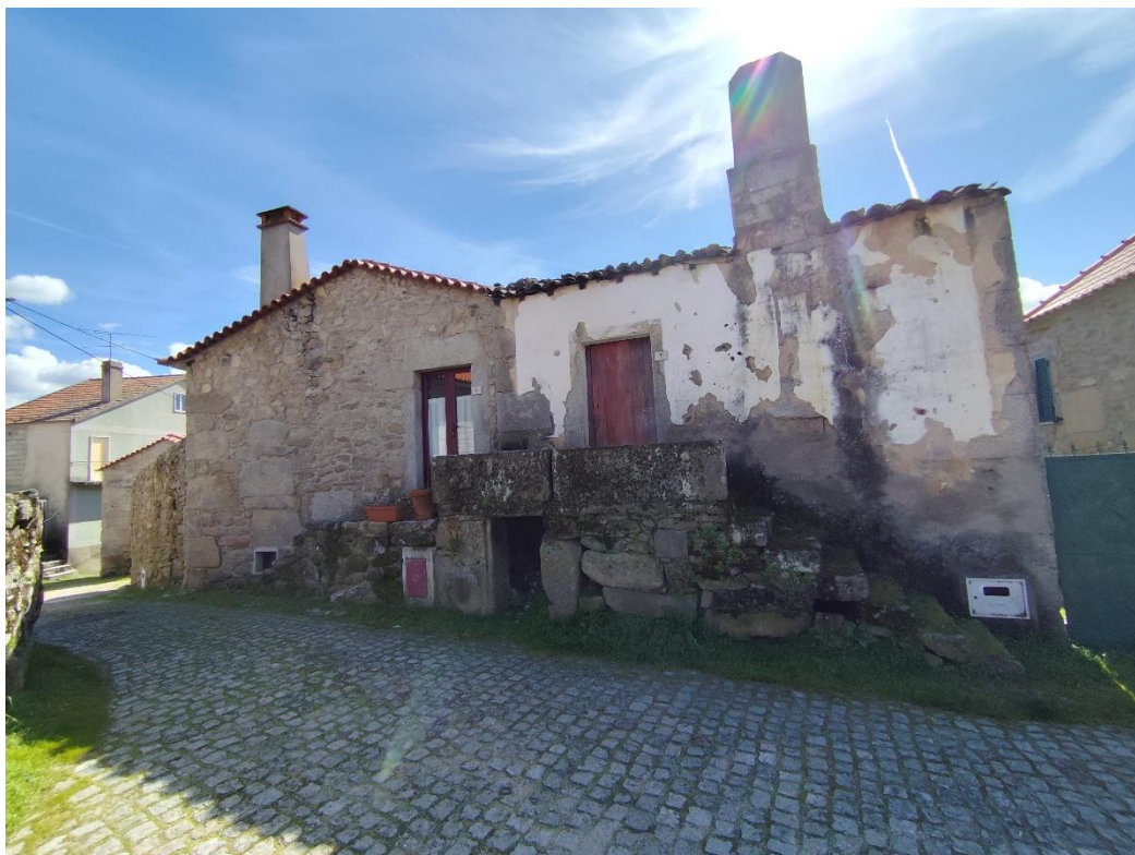
Figura 4 – perspetiva sobre Rua do Eiró, núcleo mais antigo, exemplo de reabilitado e não reabilitado
