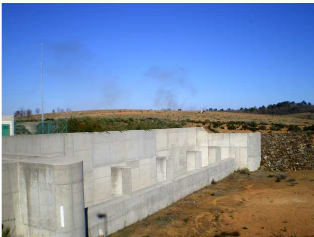
Fotografia 1 – Estrutura de entrada do descarregador de cheias da barragem do Sabugal
